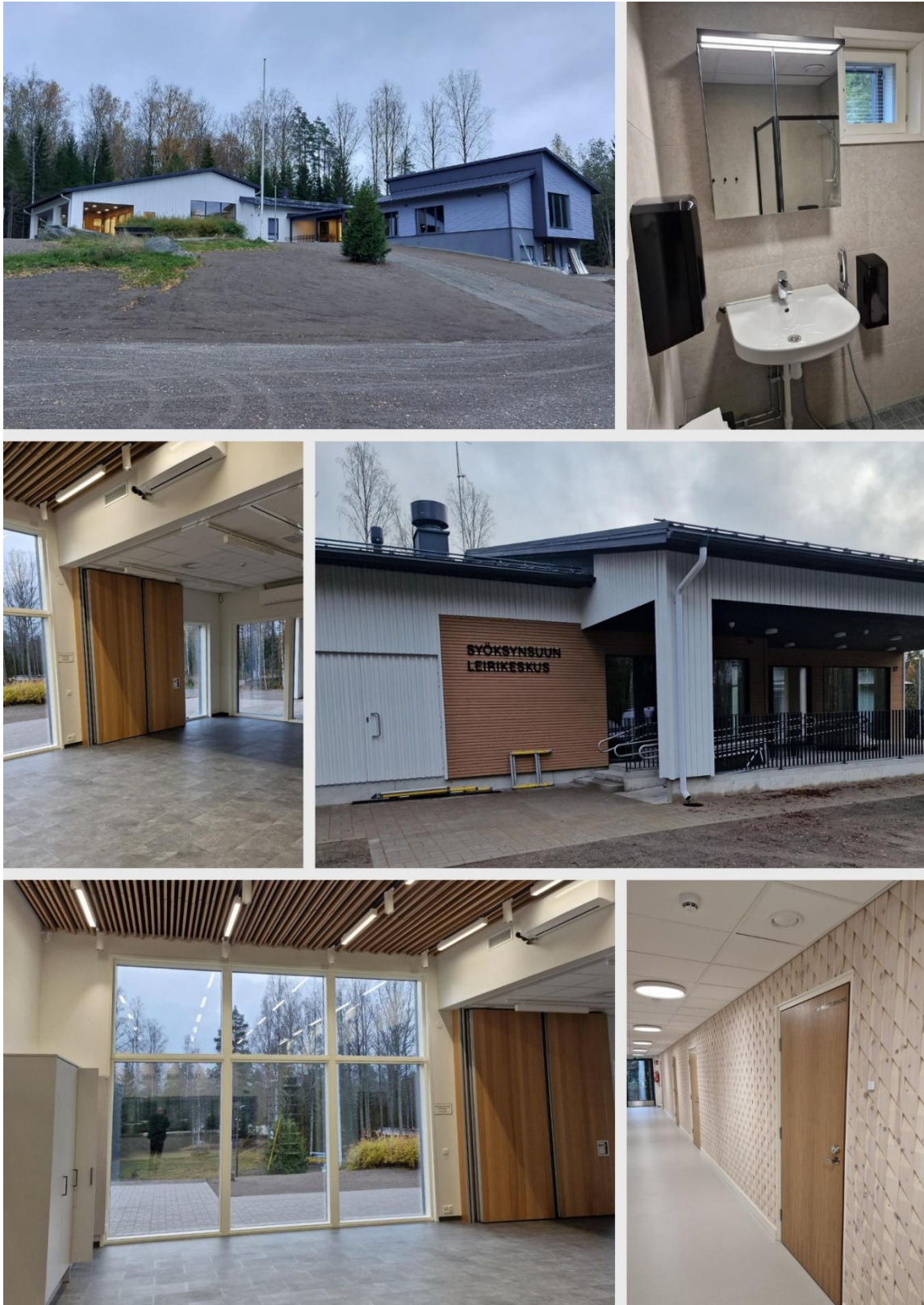
Syöksynsuun leirikeskuksen uudisrakennus valmistuu pihatöineen vuoden 2026 aikana
